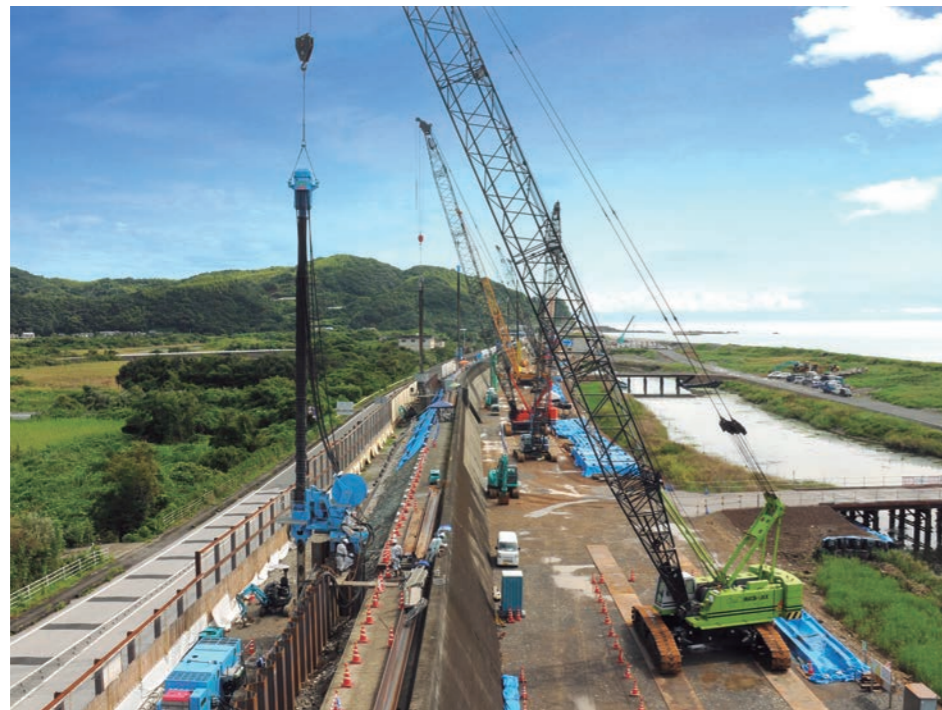
硬質地盤クリア工法による海岸堤防改良工事
