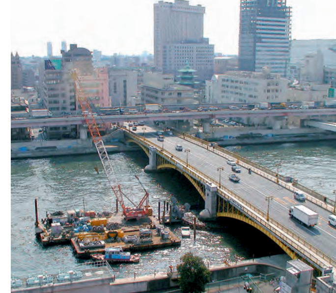
橋脚基礎耐震補強工事
