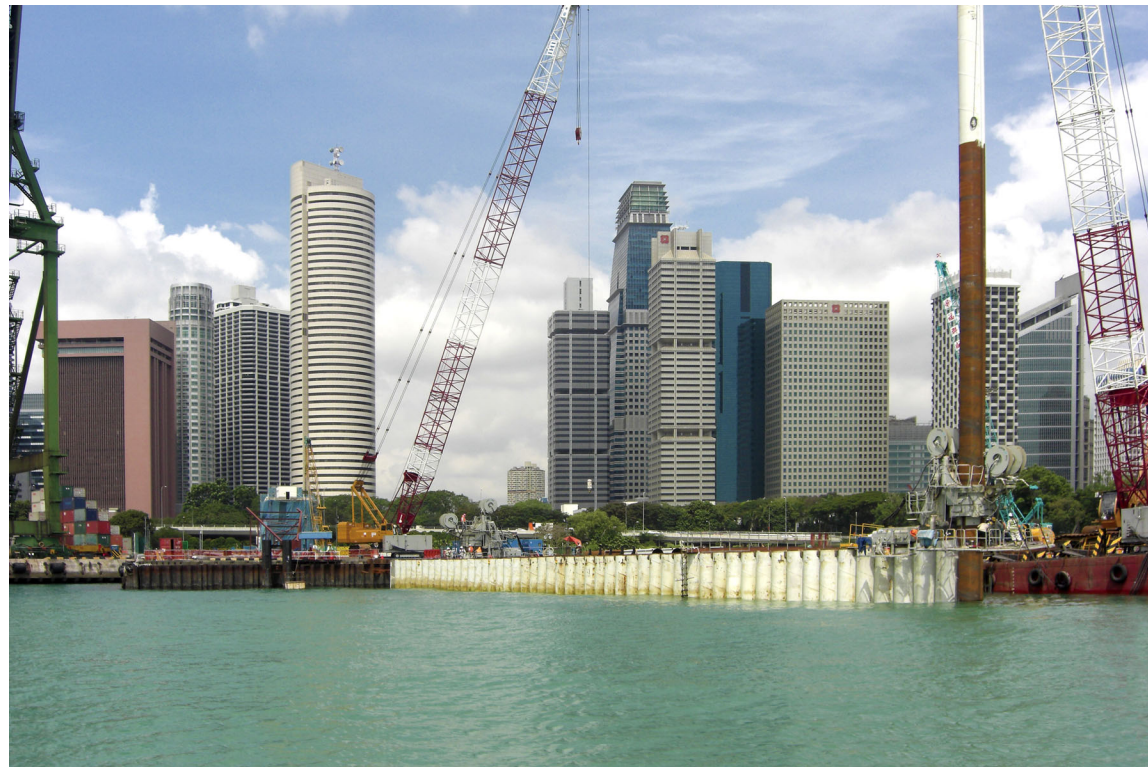
高速道路新設に伴う鋼管矢板二重締切護岸工事(シンガポール)
